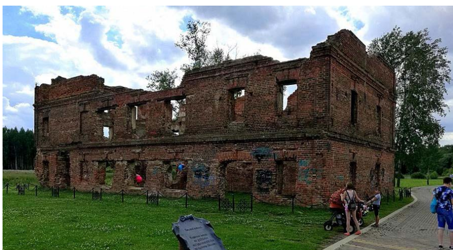
POZOSTAŁOŚCI PO STARYM MŁYNIE W ŁOSZYCY, KTÓRY MA BYĆ ODBUDOWANY
