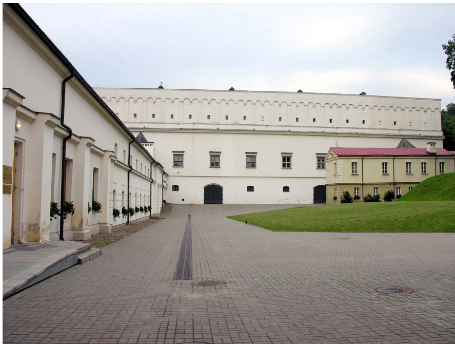
STARY ARSENAŁ W ZESPOLE ZAMKOWYM W WILNIE, OBECNIE MUZEUM SZTUKI STOSOWANEJ. STĄD WYKONANO WYSTRZAŁ ARMATNI, KTÓRY OGŁOSIŁ POCZĄTEK INSUREKCJI
