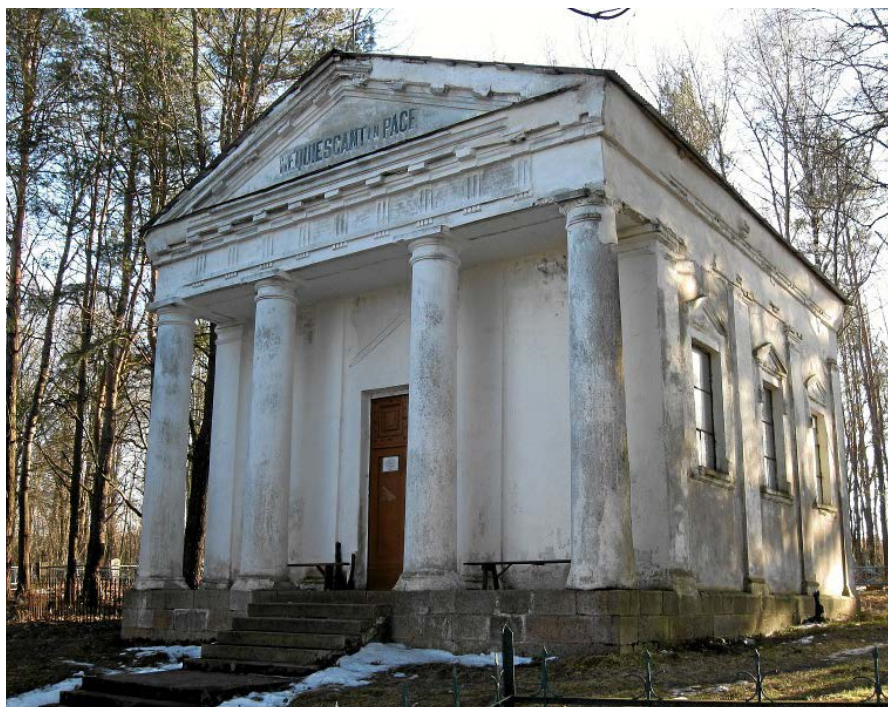
KAPLICA NARKIEWICZÓW-JODKÓW W ŁOPUSZNEJ
