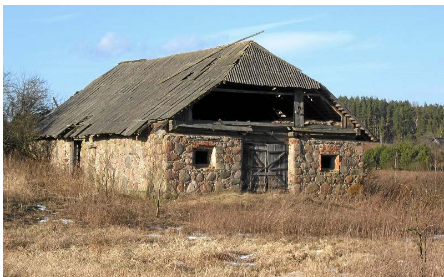
BUDYNEK BYŁEGO FOLWARKU W ŁOPUSZNEJ
