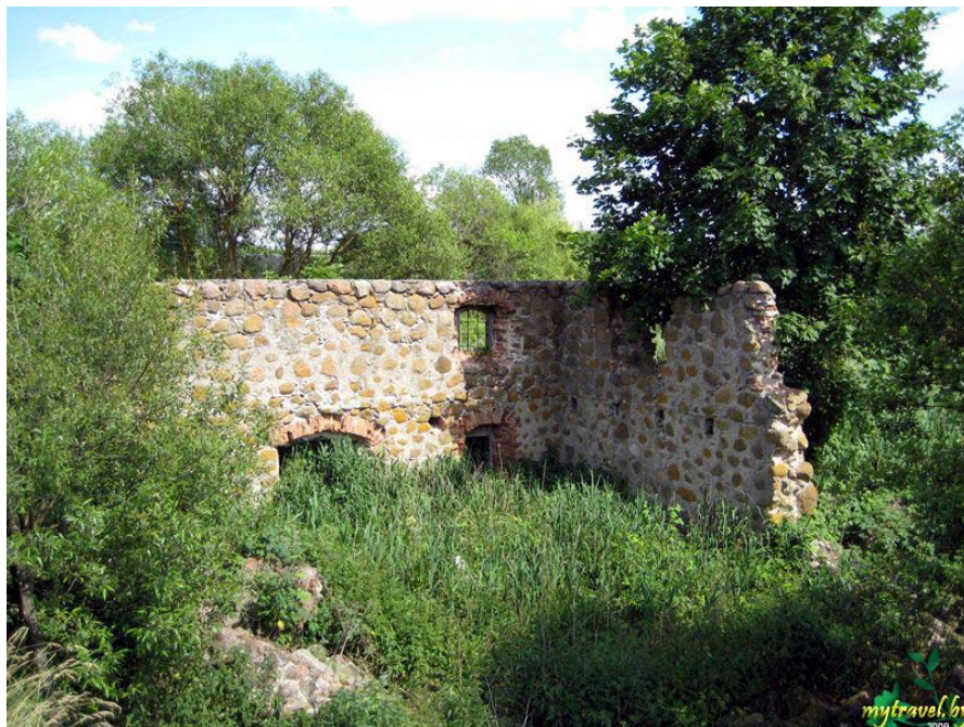
POZOSTAŁOŚCI WODNEGO MŁYNU W ŁOPUSZNEJ
